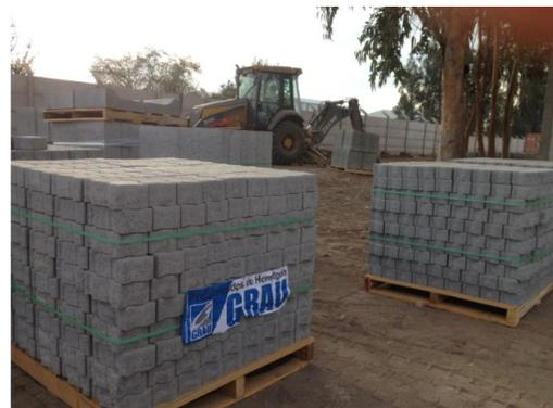
A modo de ejemplo se puede señalar un volumen de instalación (dependiendo de la cuadrilla) de 200 m<sup>2</sup> por día promedio, a través de una instalación manual, si se cuenta con máquina para instalar Adocreto los volúmenes que se manejan están alrededor de los 400 m<sup>2</sup> día.
