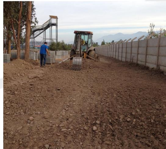
Ejemplo de preparación de superficie mediante escarpe, en la fotografía se levanta capa superior del relleno.
