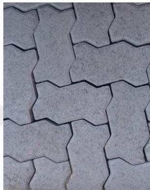
Imagen de Adocretos instalados antes del relleno de las juntas
